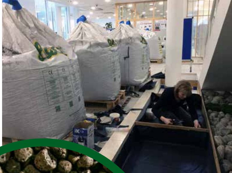
Arja Rantasalo sikrer, at kasserne er vandtætte, inden Leca® letklinker og vand hældes i.
