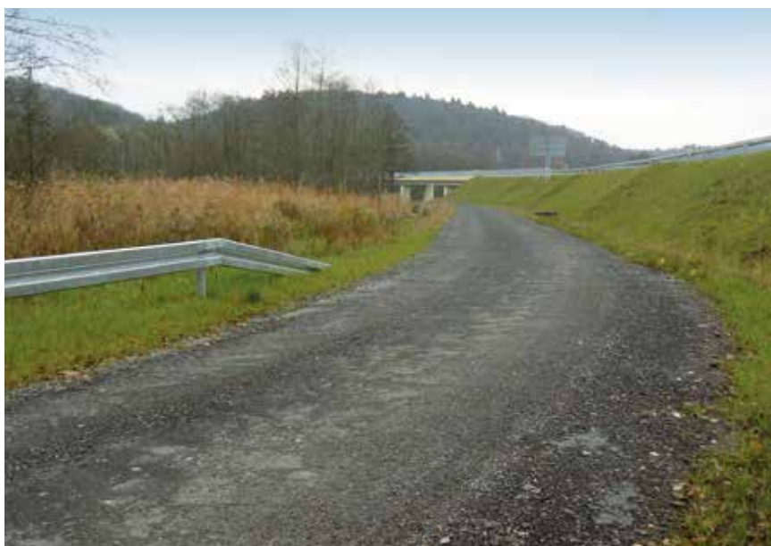
Det var nødvendigt at bygge flere serviceveje.
