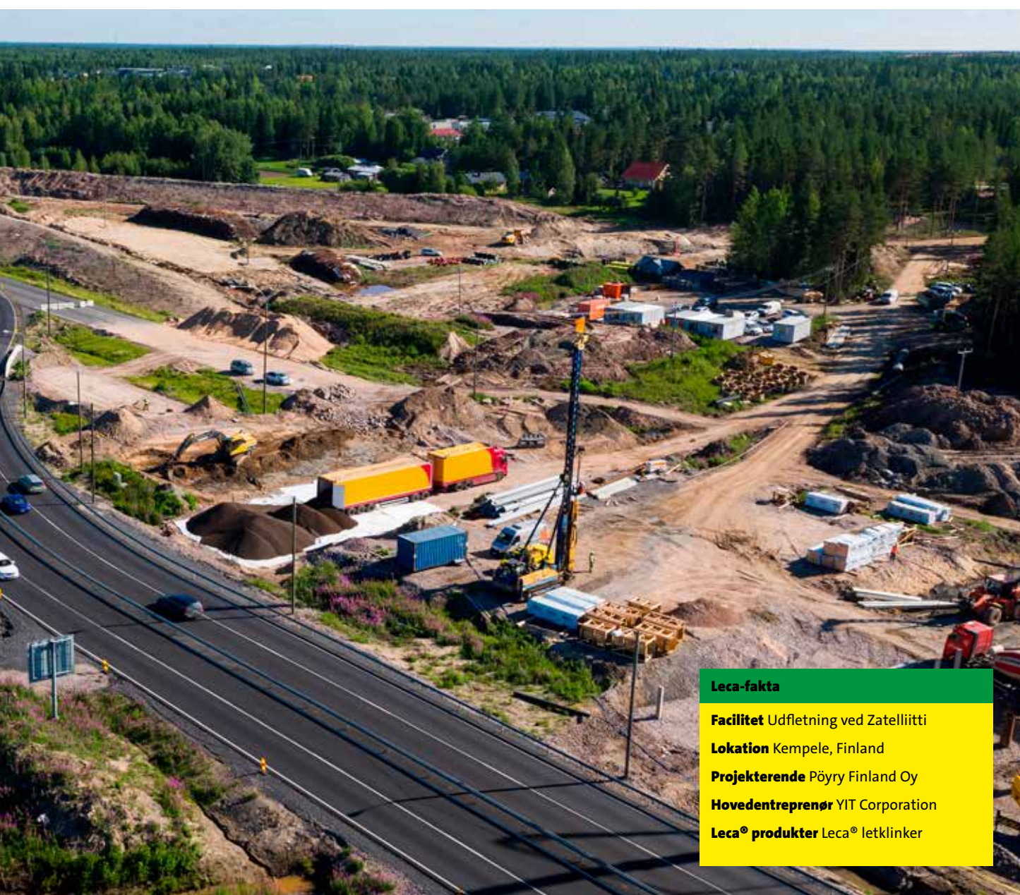
Letvægtskonstruktionen blev komprimeret i lag på ca. 0,5 m.
