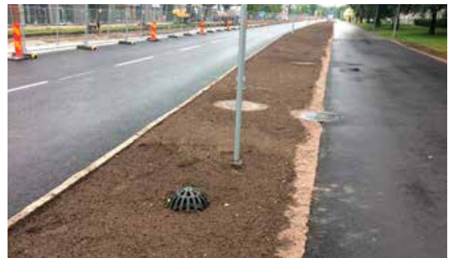
Efter udlægningen kan man ikke se det. Materiale udskiftes gennem mandehullerne.
