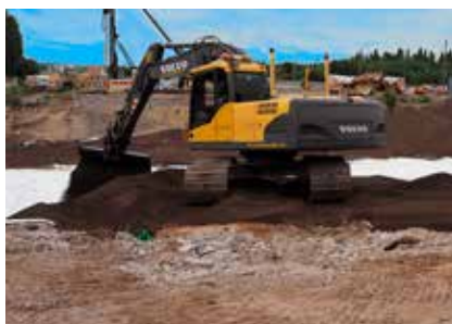
Letvægtskonstruktionen blev komprimeret i lag på ca. 0,5 m.
