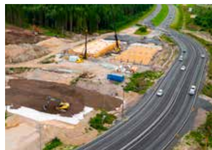
Letvægtskonstruktion til nye vejbaner på motorvejen.
