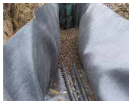
Elkabler lagt i geotekstil fyldt med løse Leca® letklinker.
