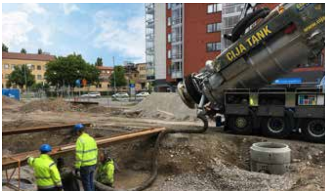
Materialet blev hurtigt blæst på plads ved hjælp af en blæsebil.
