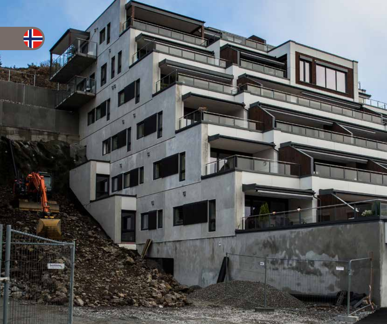
Den ene af de tre blokke , som Betonmast Telemark bygger i Hokksund.
