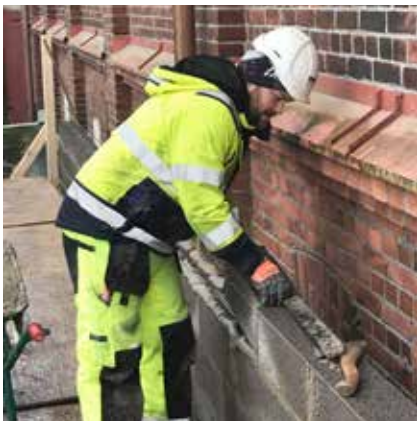
Håndværkerne havde en positiv oplevelse med bygning af brandmuren.
