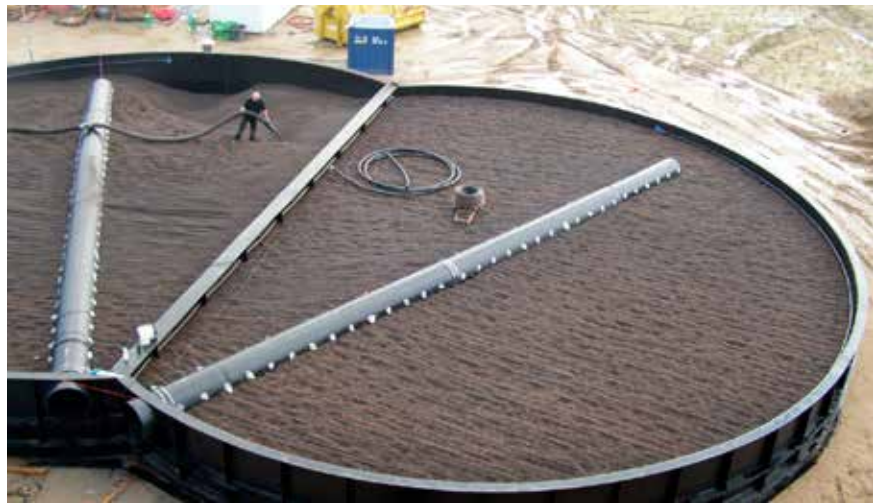
Lugtrensingsfiltret fyldes. Rørene øverst er afløb for den rensede luft
