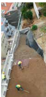
Åbningen mellem den nye mur og den eksisterende skråning blev fyldt med Geo Leca®.
