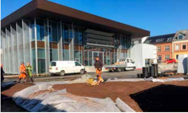
Løse Leca® letklinker blev brugt til at skabe bakkerne. Ovenpå disse blev der lagt et lag Leca® Beton og til sidst blev der udlagt et lag asfalt.
