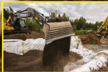
I alt blev der brugt ca. 2.500 m³ Leca® letklinker til opgaven.
