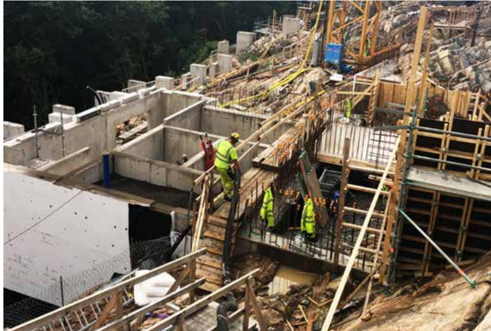
Leca® letklinker leveres på byggepladsen.
