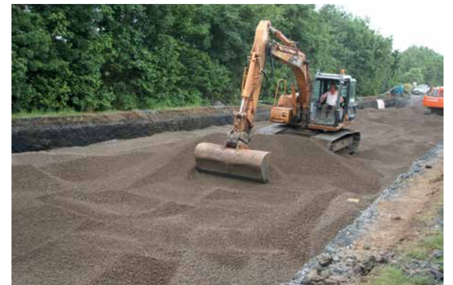
Letklinkernes styrke og komprimeringsegenskaber gav mulighed for de tunge køretøjer kunne udføre installationen
