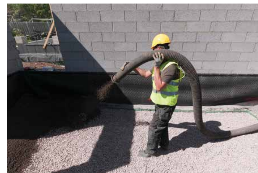
Pneumatisk levering var en hurtig og nem løsning
