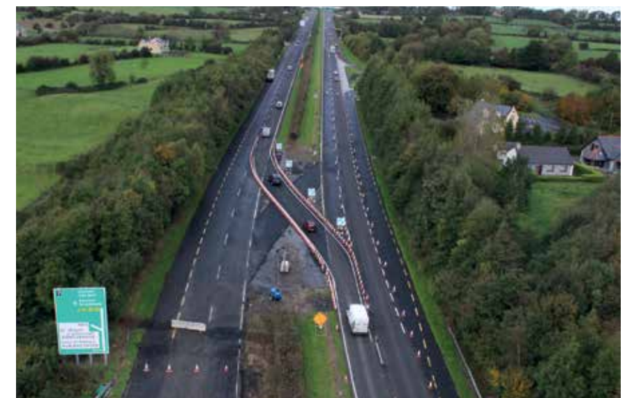
Leca letklinker var et vigtigt komponent til rekonstruktionen af den eksisterende 1,6 km tosporede vej
