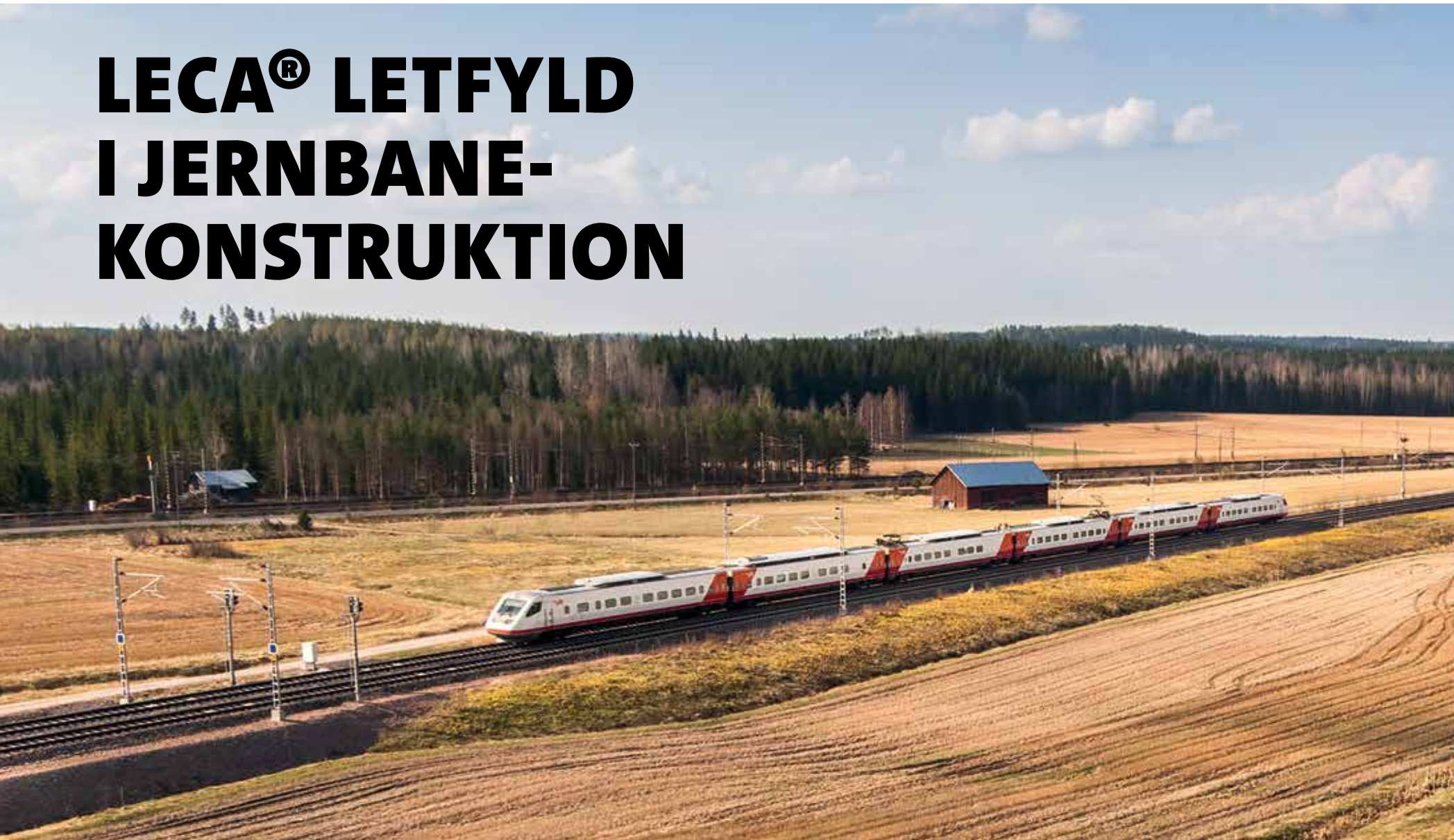
En højhastigheds jernbane imellem Kerava og Lahti er på steder anlagt i lavtliggende områder med tyk, blød underbund
