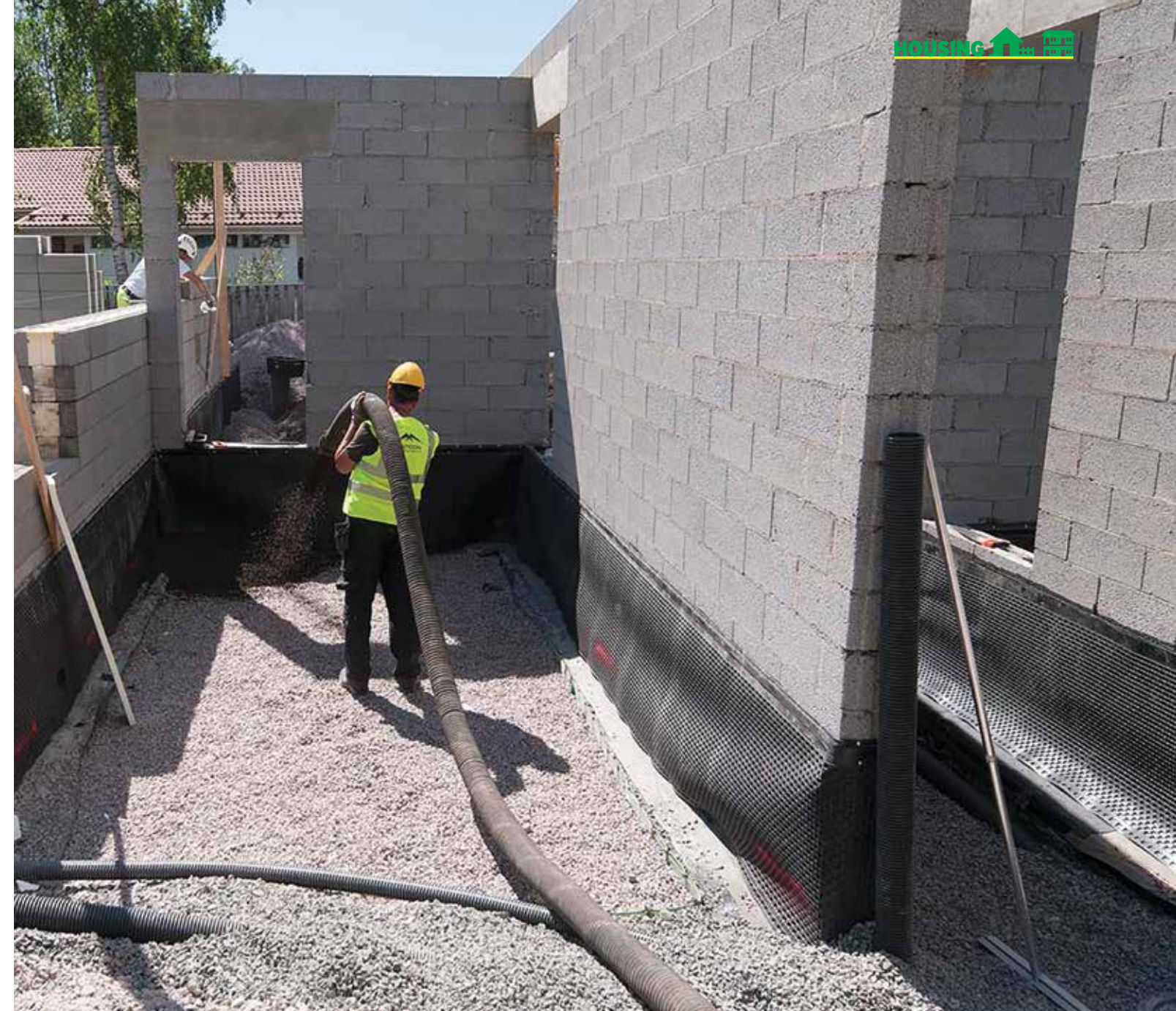
Et lag på ca. 700 mm blev blæst ind i fundamentet af hver garage.
