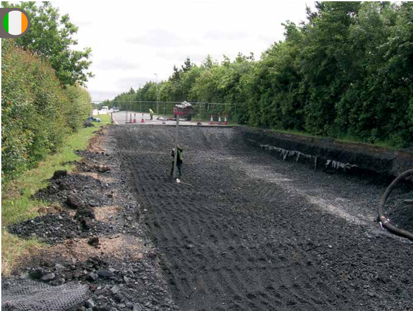
Leca letklinker blev brugt til at erstatte tungt vejkonstruktionsmateriale
