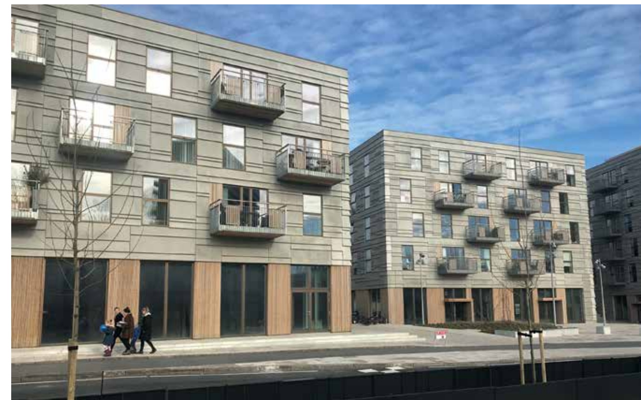
Leca letklinker blev brugt som indskudsdræn og som letfyld oven på garagen
