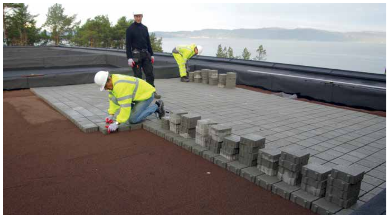
Det knuste Leca-materiale er skjult under belægning i det blå-grå vandhåndterings-pilotprojekt ved Høvringen i Norge.
