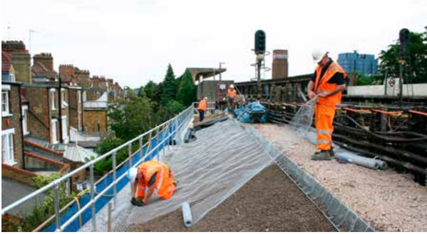
Dæmningens vægge stabiliseres langs en 200 m lang London Underground-strækning mellem Acton Town og Chiswick Park.
