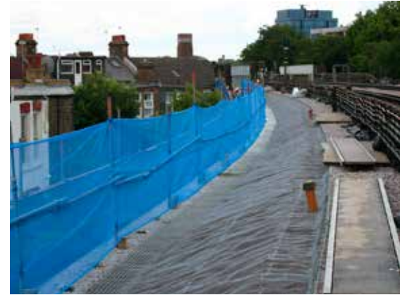
Dæmningens vægge stabiliseres langs en 200 m lang London Underground-strækning mellem Acton Town og Chiswick Park.
