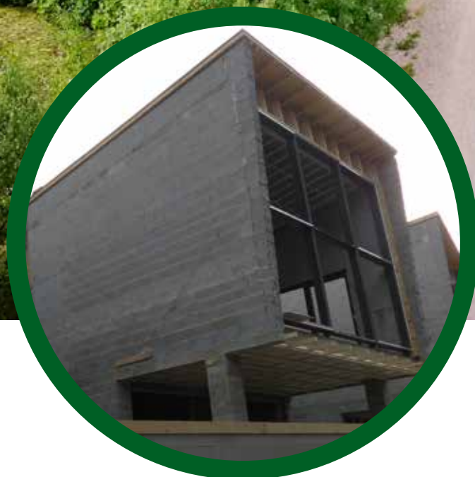
Familierne valgte 380 mm tykke Leca® sandwichblokke som det primære rammemateriale.
