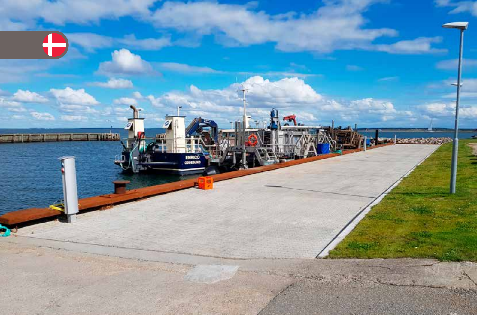
Den færdige kaj med asfalt ovenpå Leca letklinkerne.
