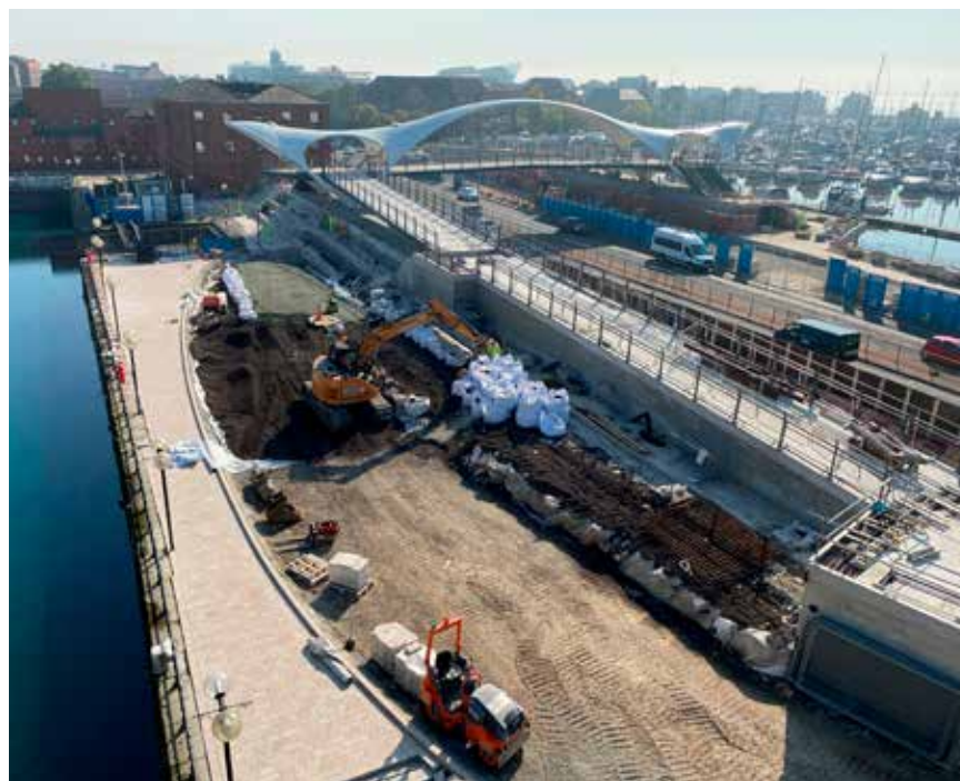
Leca letklinker blev specificeret som et fyldmateriale, der fyldte et rum, der var 6 m i dybden.
