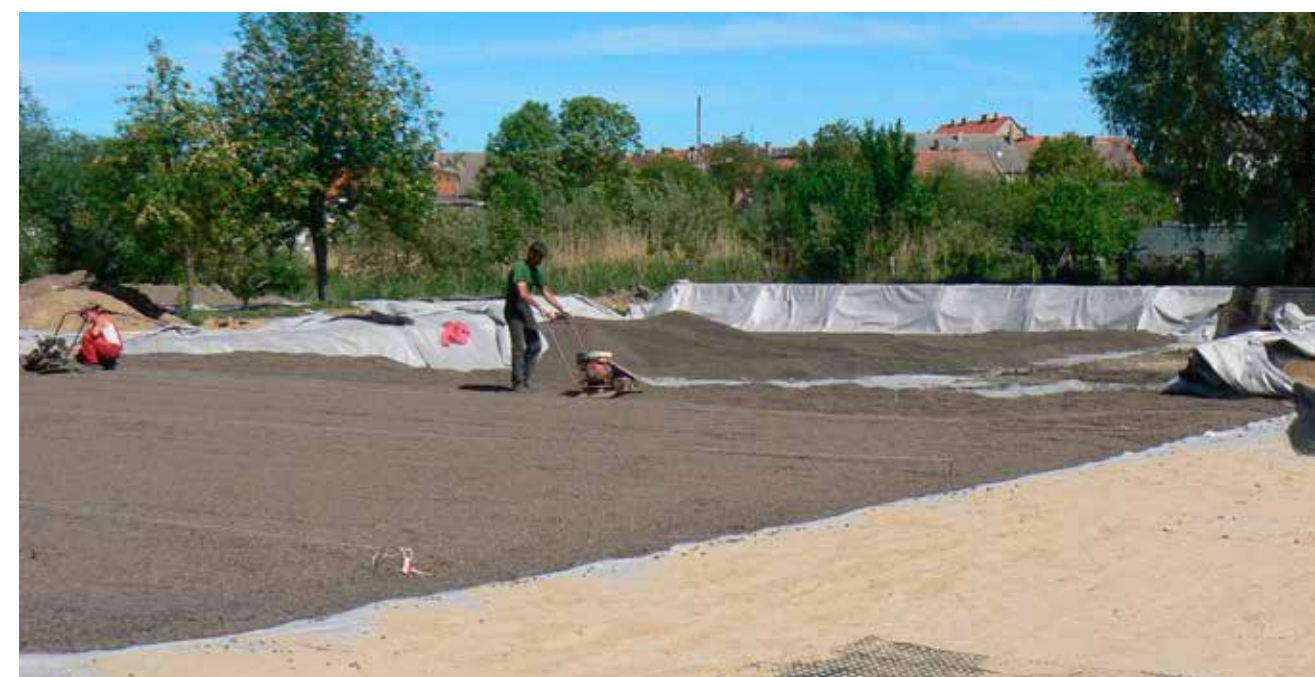
Det første lag Leca letklinker bliver lagt ud.
