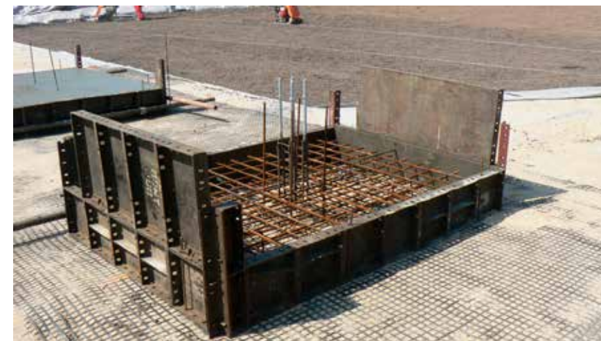
Fundamenter på letvægtsaggregat.
