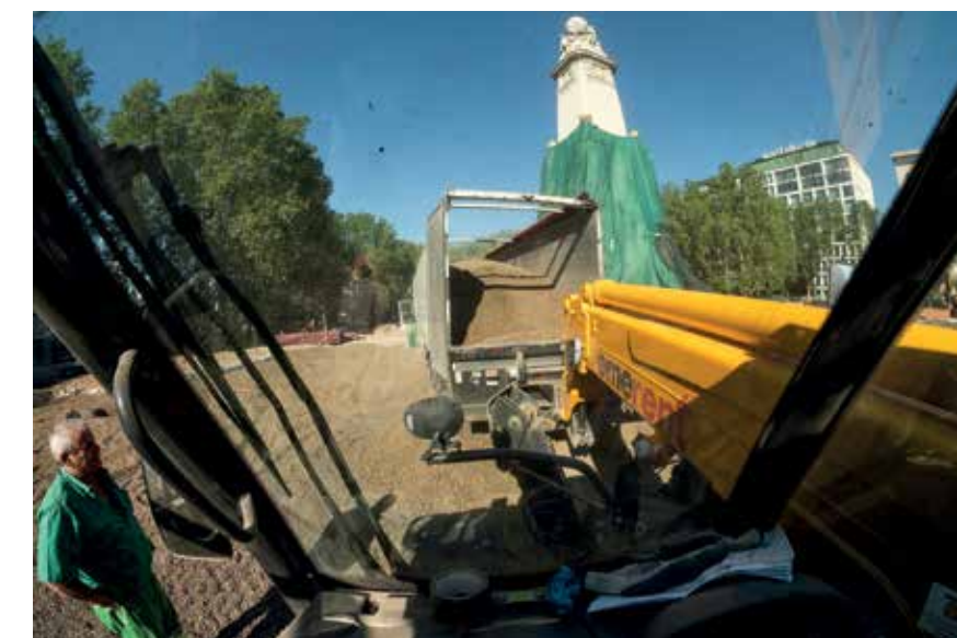
Aflæsning af Leca letklinker fra en lastbil med en kapacitet på 75 m 3 .
