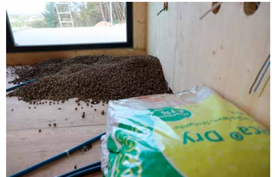
Leca Dry er et let og tørt ekspanderet leraggregat med et restfugtighedsindhold under 1%.
