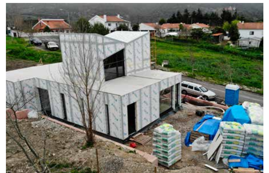
Sekshundrede poser med Leca Dry blev brugt til at isolere gulvene.
