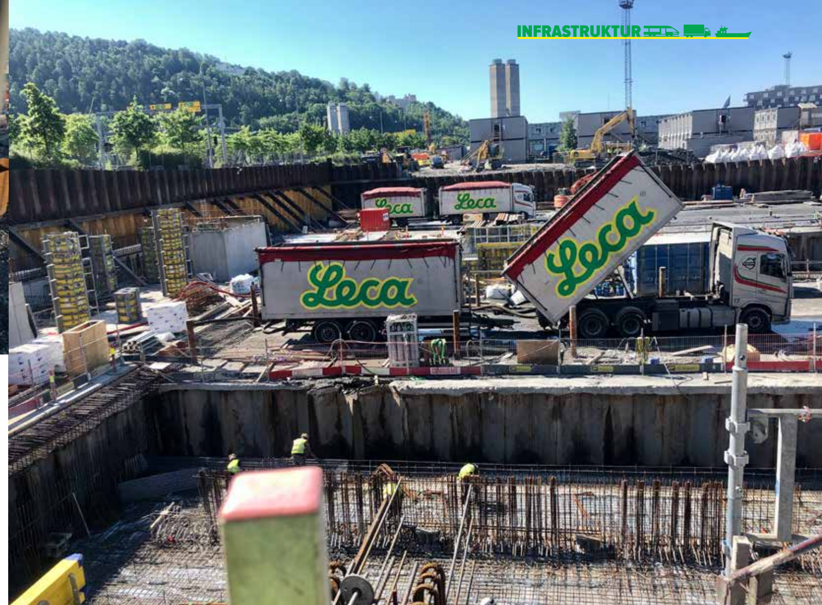
"Effektiv logistik gør konstruktionen lettere for design- og bygningsentreprenøren," bekræfter Ola Hammer. Her ses hvordan Leca letklinker blæses let på plads.
