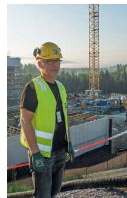
Byggepladschef Svein Harald Øyhus venter på dagens første Leca-levering i morgensolen.
