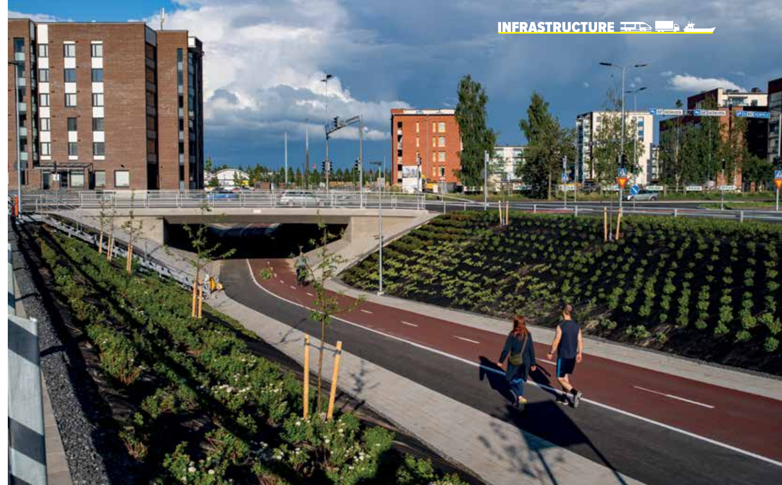
Rautionpolku-tunnelen blev afsluttet i november 2019.
