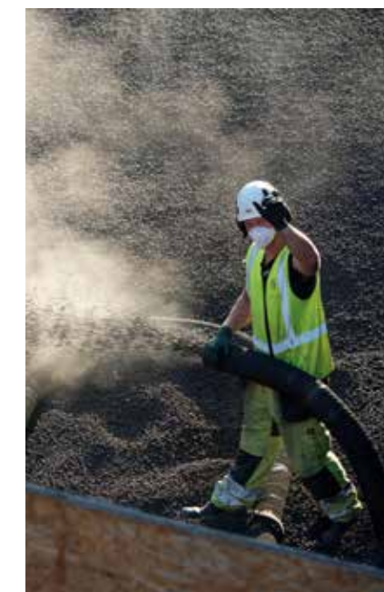
Letklinkerne dræner og isolerer samtidig med de reducerer belastningen på væggene.
