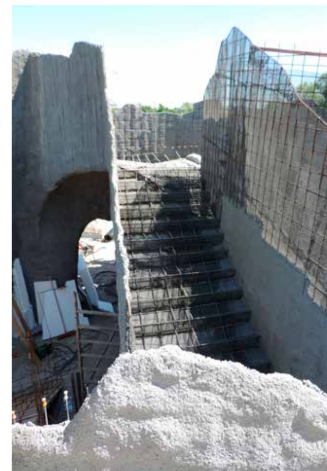
Under trappen og platformen ligger Leca letklinker.
