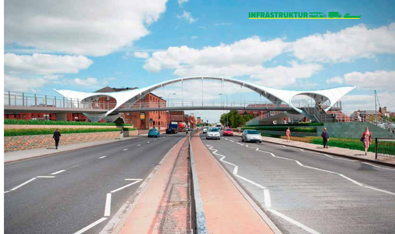
Leca letklinker blev specifikt specificeret til opbygning af dæmningen der skal understøtte gangbroens adgangsstier.
