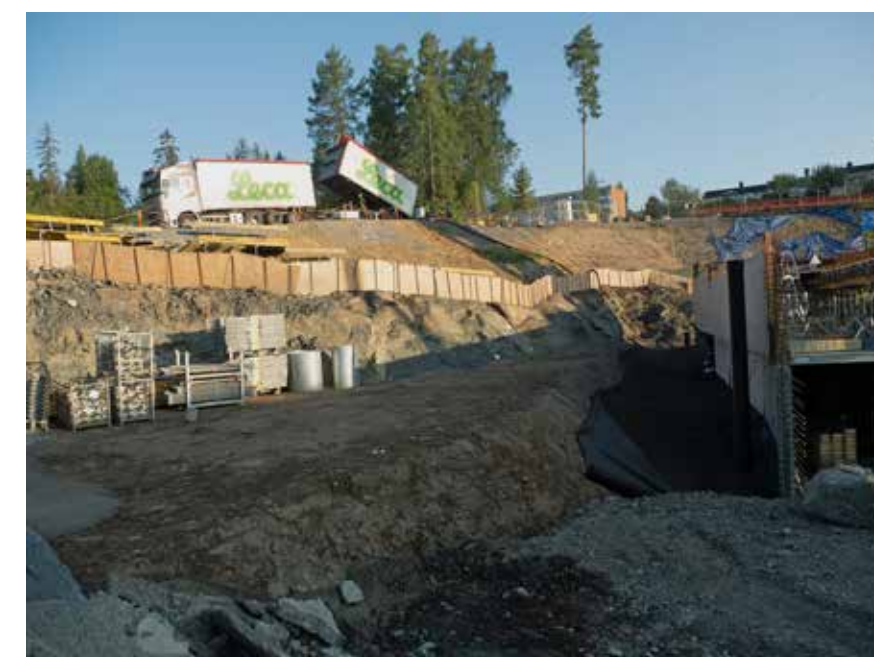
Når man arbejder i stejlt terræn og har brug for at få Leca letklinker ned i en byggegrav og rundt om hjørner, er det ideelt at kunne blæse dem på plads.
