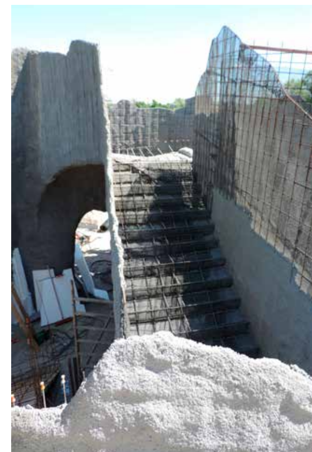
Under trappen og platformen ligger Leca letklinker.
