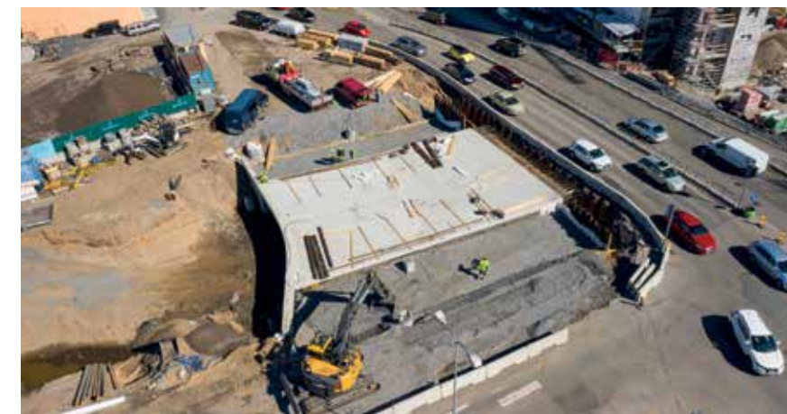
Der blev lavet et mellemlager for materialet på byggepladsen.
