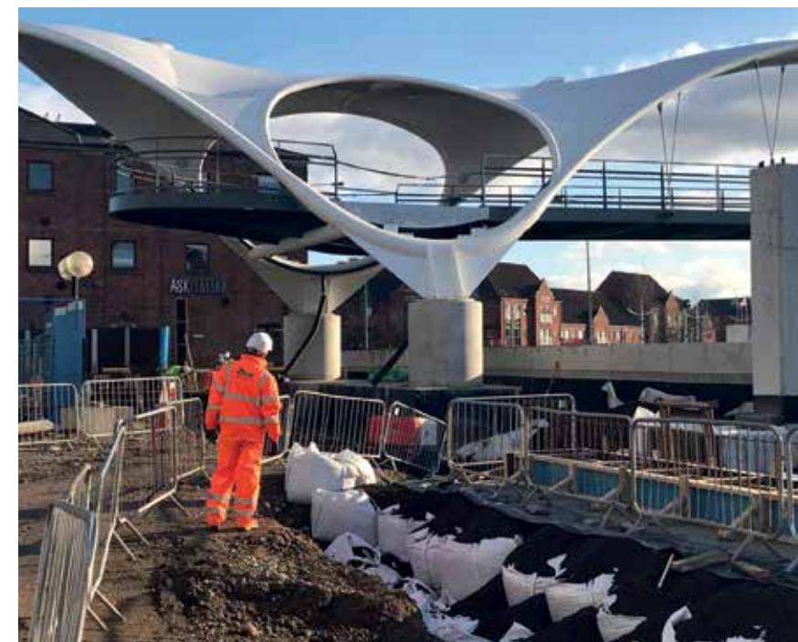
Leca letklinker blev specificeret som et fyldmateriale, der fyldte et hul, der var 6 m i højden.
