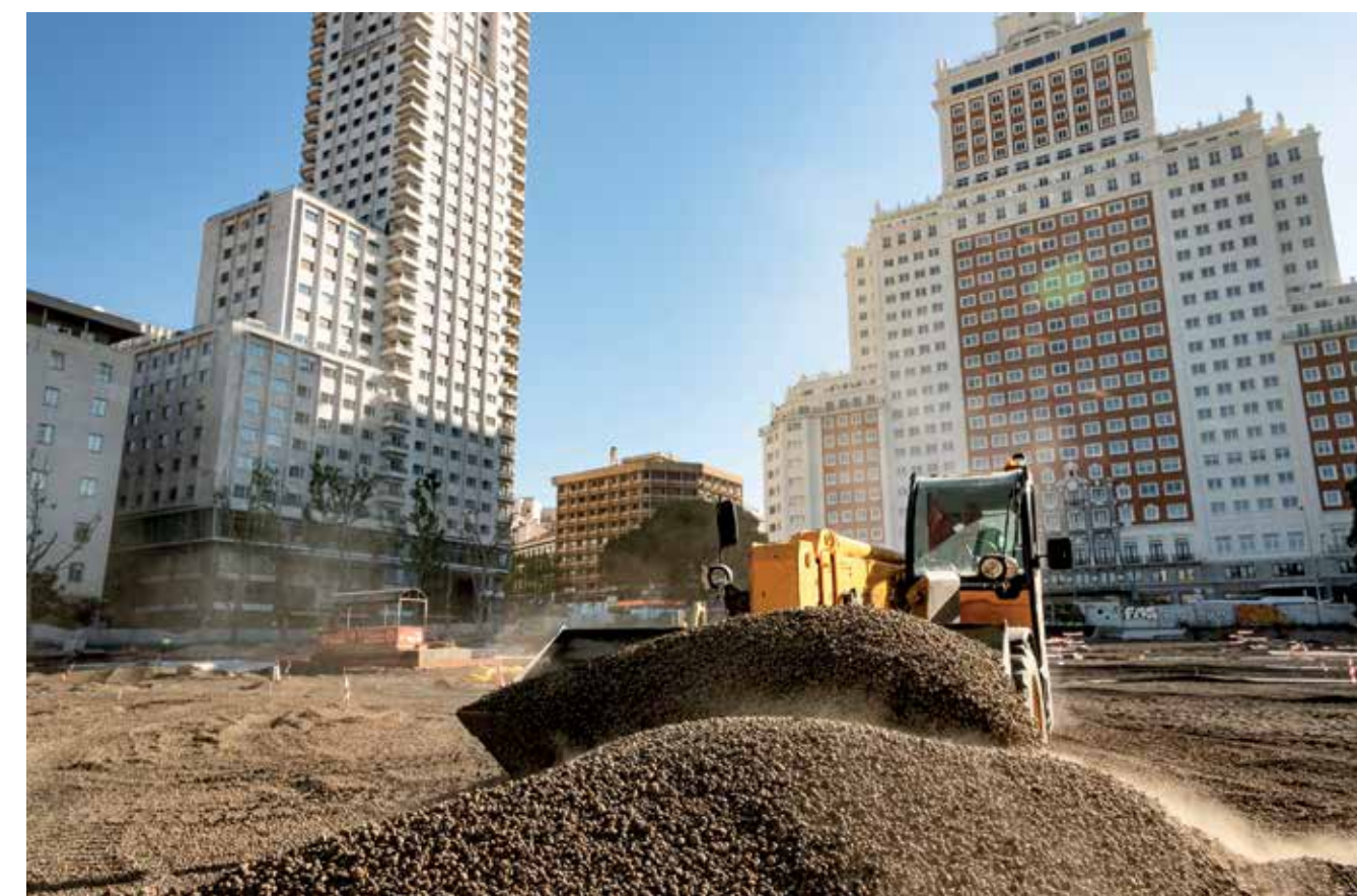
Udlægning og komprimering af Leca letklinker på den 10.000 m 2 store plads.
