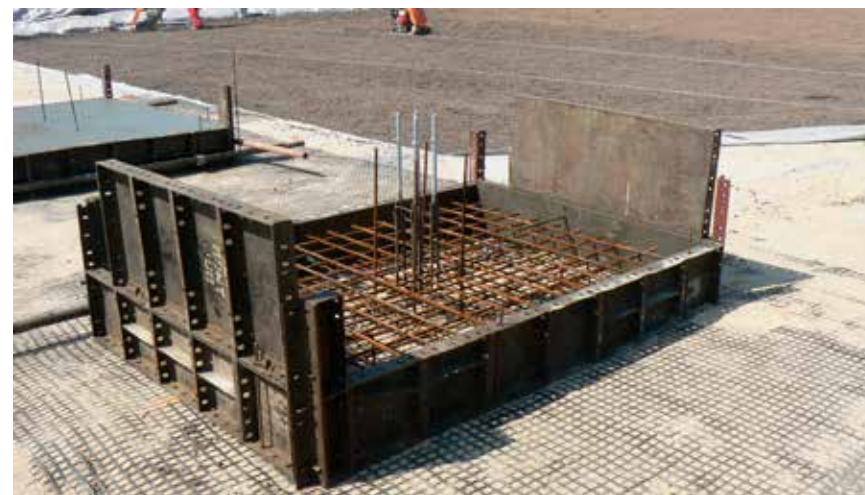
Fundamenter på letvægtsaggregat.
