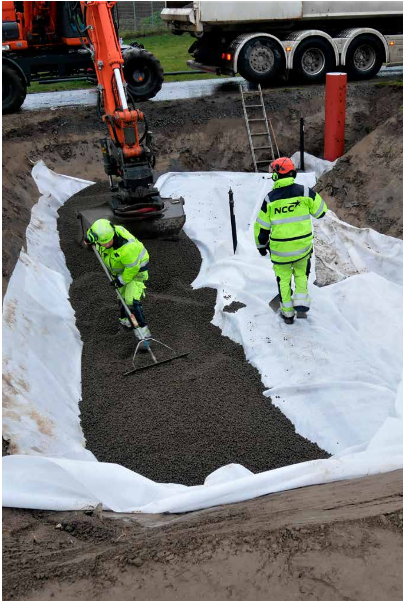
Når der udvikles en ny løsning til fyld omkring kloakrør, udføres en test i fuld skala, hvor den skal udføres.
