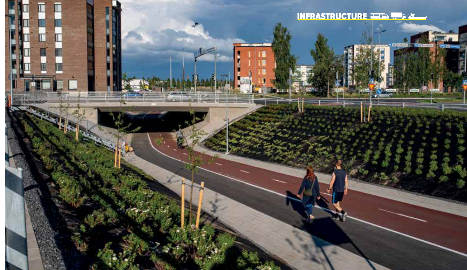
Rautionpolku-tunnelen blev afsluttet i november 2019.
