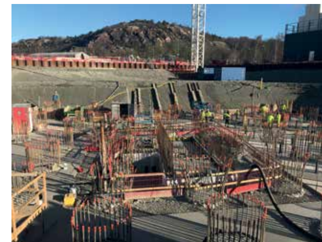
Leca letklinker blev leveret med blæsebil til midten af tårnets fundament.
