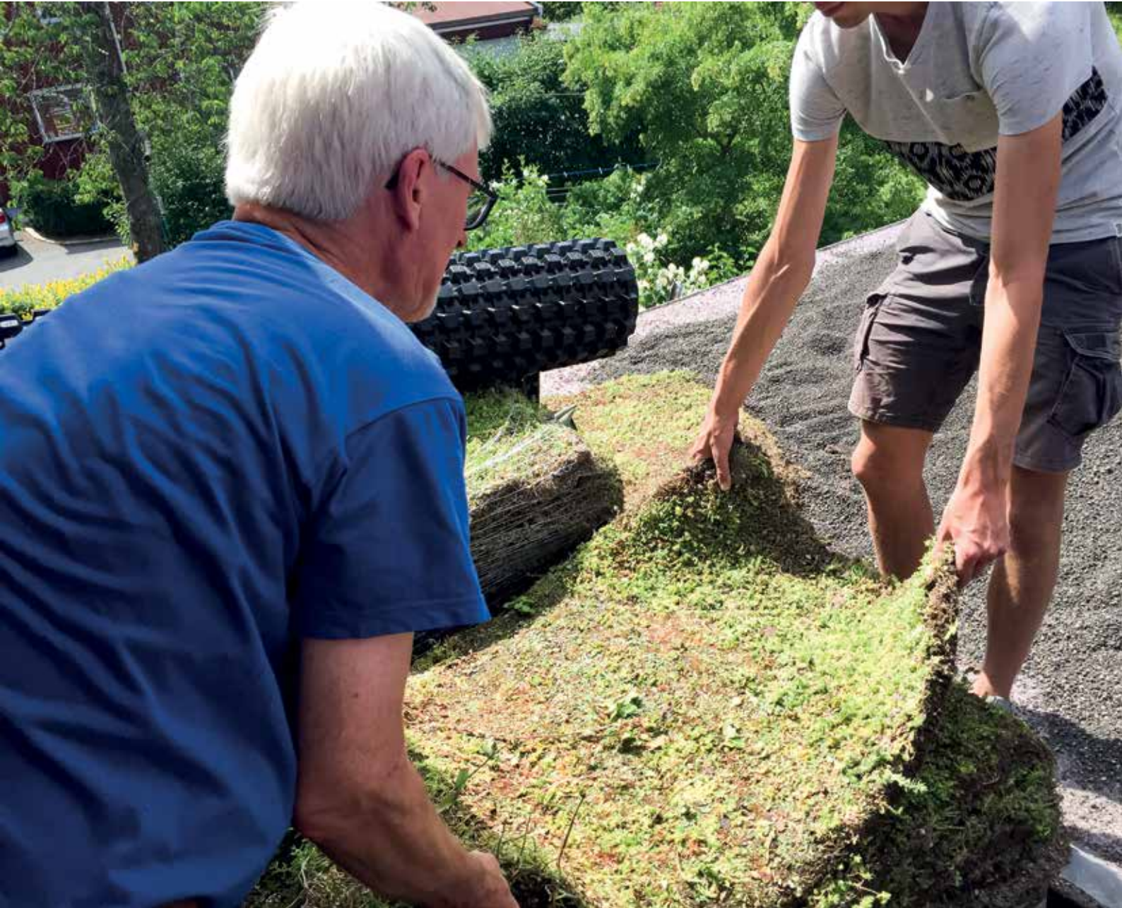
Knust Leca 0-6 mm blev brugt til at maksimere vand tilbageholdelse, da Bent C. Braskerud installerede et grønt tag på sit hjem i Oslo
