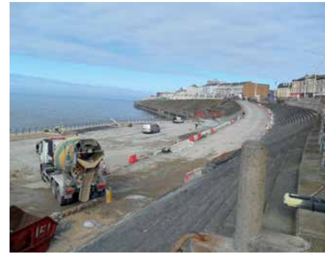
4.000 m³ Leca letklinker blev brugt til at opfylde hulrummet mellem det eksisterende forsvar og en ny kystsikringsmur.
