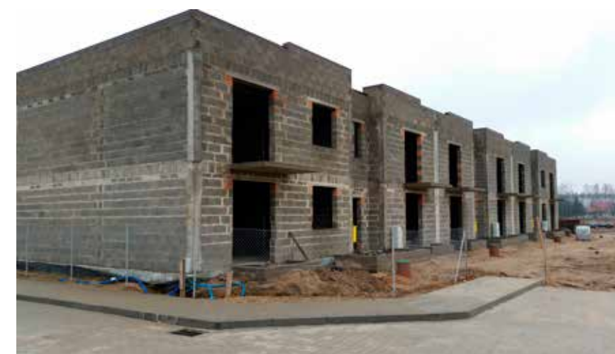
En rækkehus under opførelse.
