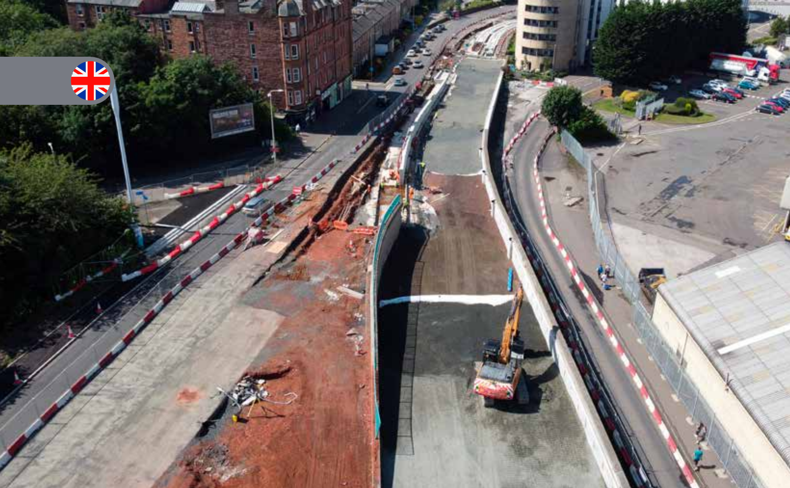
Leca letklinker med succes blev indbygget for at vægkompensere på undergrunden.
