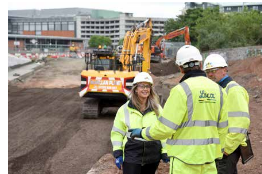
Leca letklinker blev foreskrevet som en letvægtsløsning for at give en robust fundamentsstøtte til sporlejet mellem to eksisterende støttmure.
