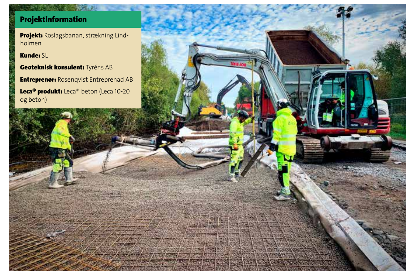
LLP er en innovativ løsning, der opnås ved at kombinere Leca letklinker og en cementblanding ved hjælp af en specielt udviklet dyse.
