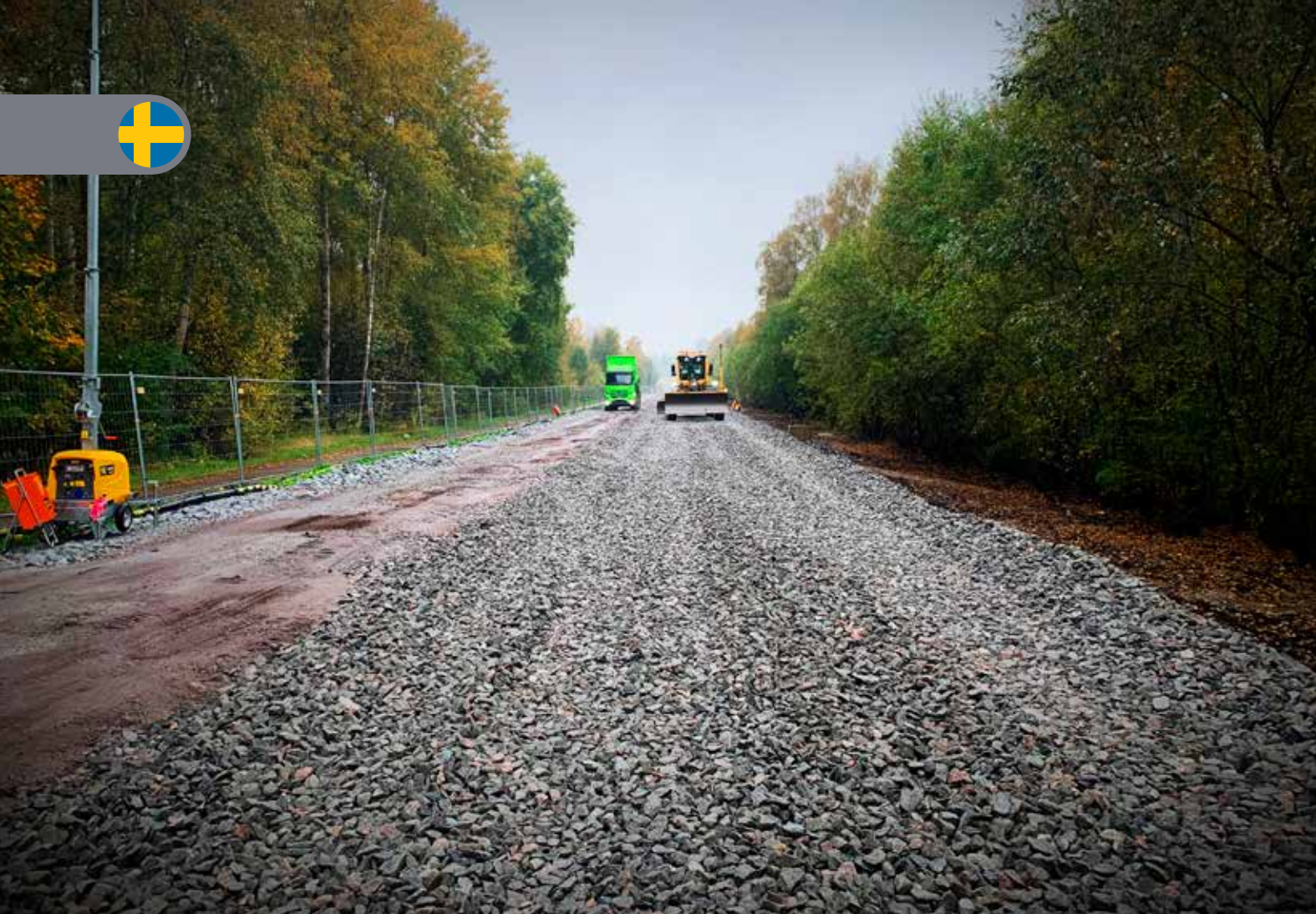
Oven på den færdige Leca-løsning blev der lagt knuste sten, inden de nye jernbaneskiner blev lagt.
