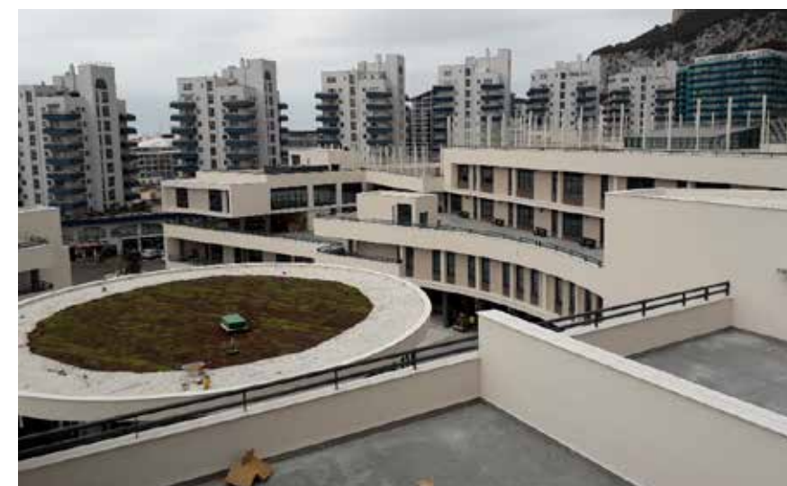
I alt 430 tusind forskellige Isoargila-blokke blev brugt til at konstruere de to bygninger.
