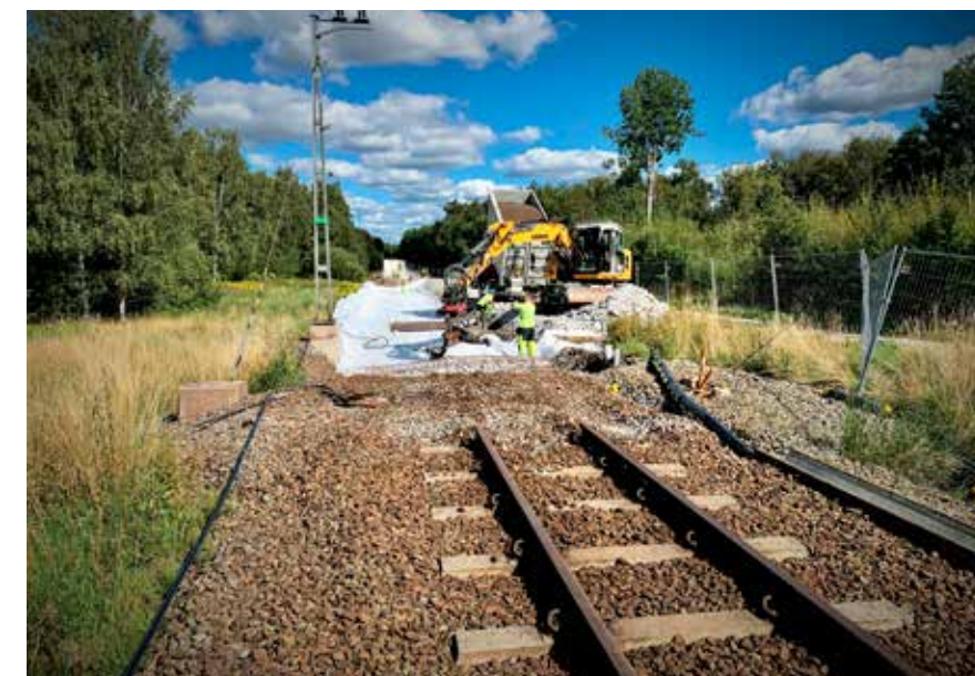
I bunden af LLP-laget er der udlagt geotekstil.
