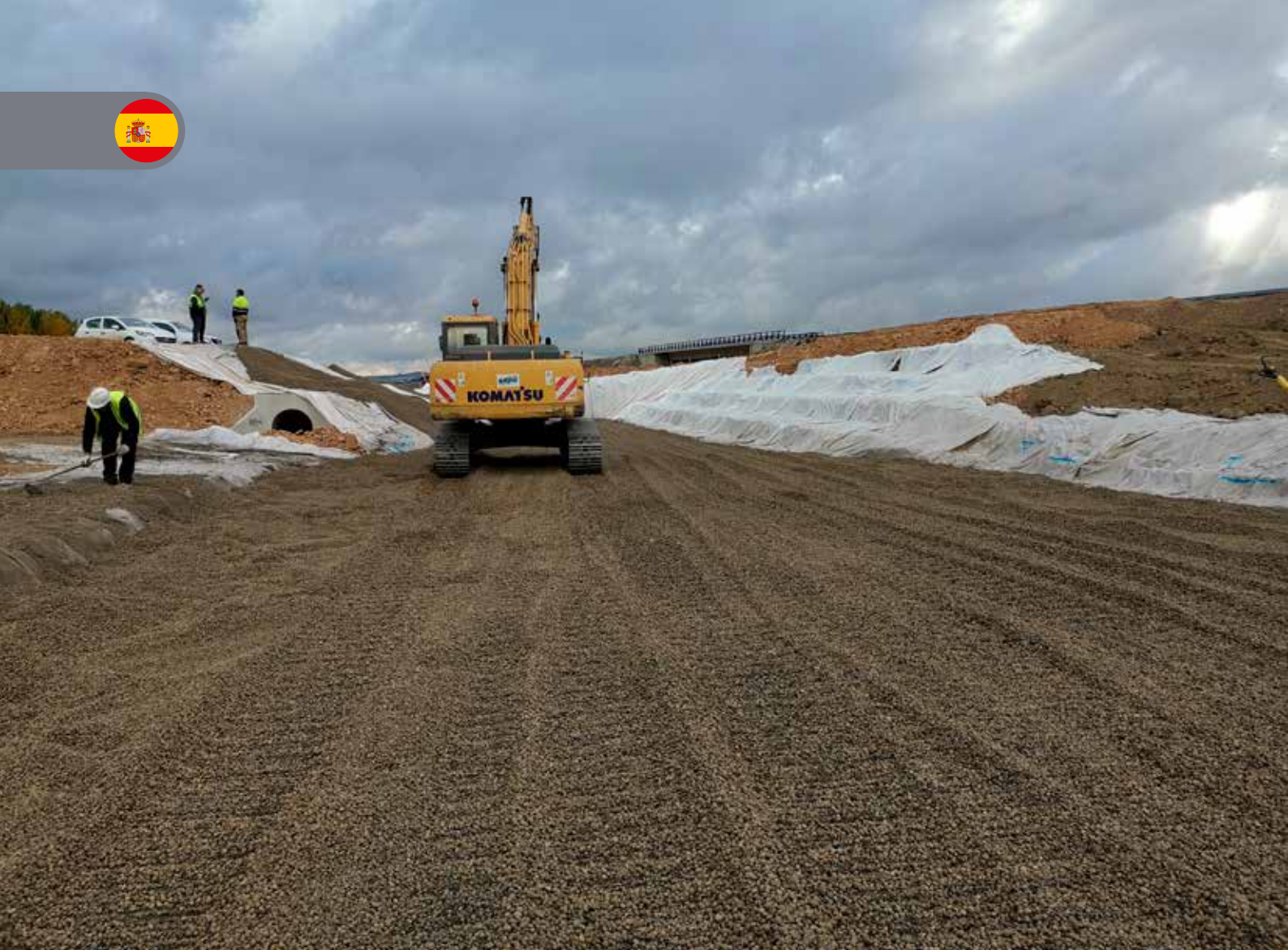
Udlægning og komprimering af Leca letklinker.
