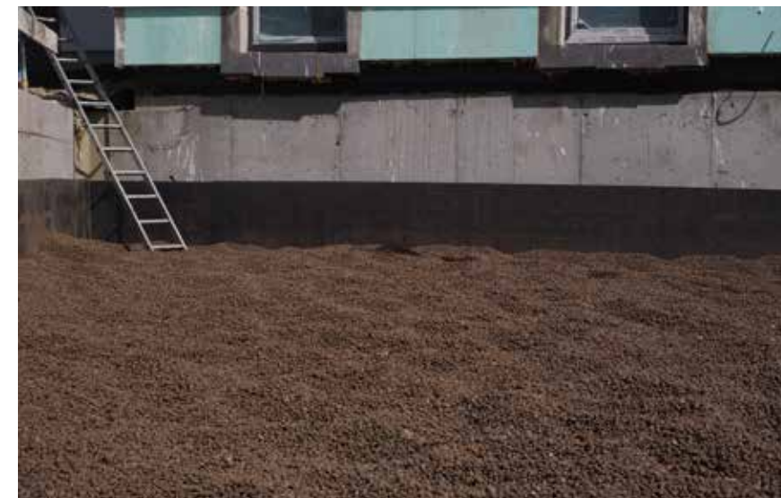
Påfyldning ved siden af bygningen og støttemure
