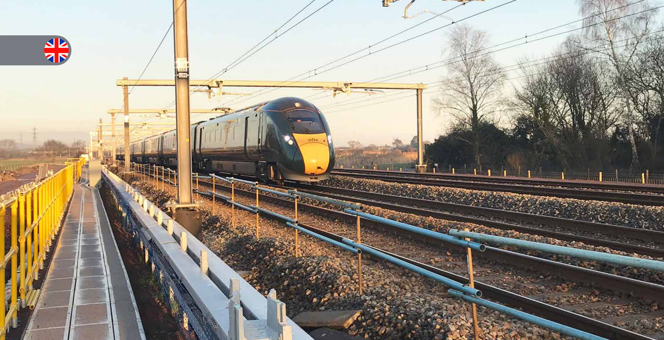
Over 1000 m 3 Leca letklinker blev foreskrevet til en ny 340 m lang og 2 m høj jernbanedæmning i St Brides, Newport, South Wales
