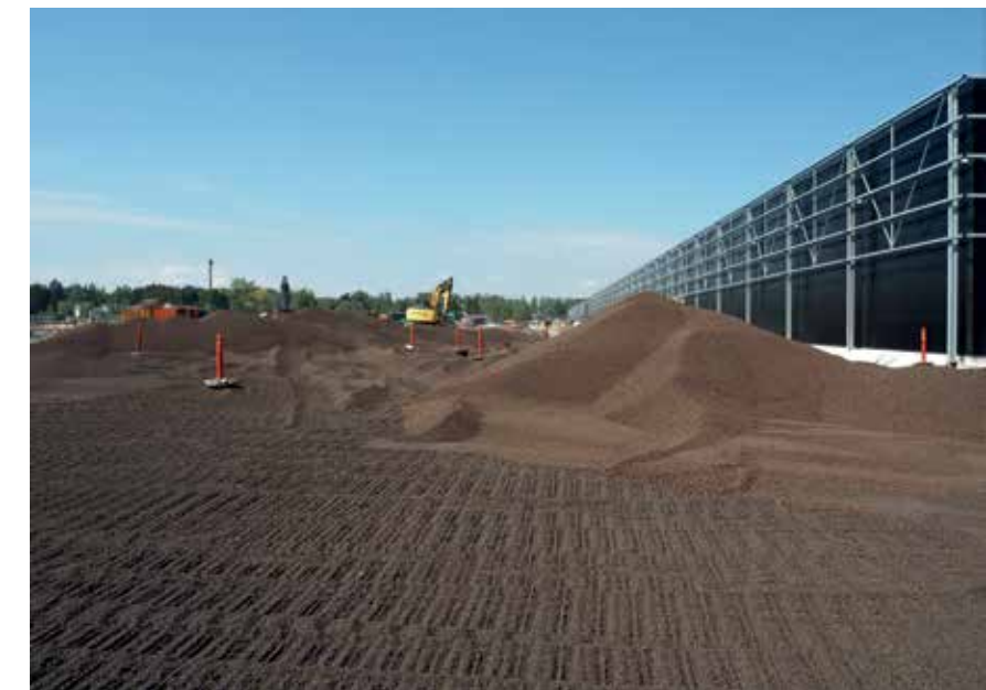
Tykkelsen af Leca letfyld-laget i opbygningen af parkeringsarealet varierer mellem 300 og 1.200 mm.
