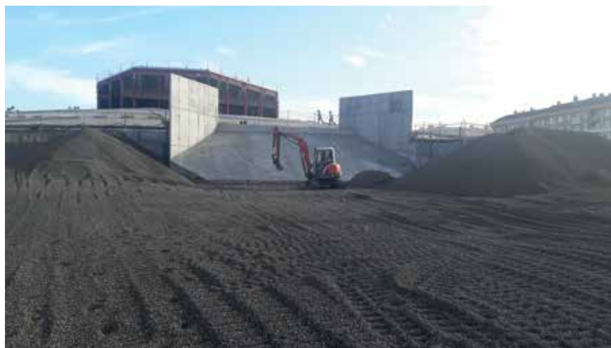
Arlita letklinker bliver komprimeret.
