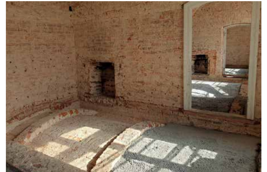
Et af de renoverede lofter/gulve.
