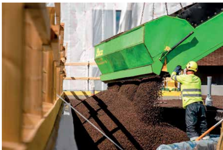
Letklinkerne blev hurtigt leveret med en løftekasse.
