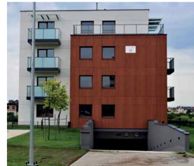
Indkørsel til p-kælder.
