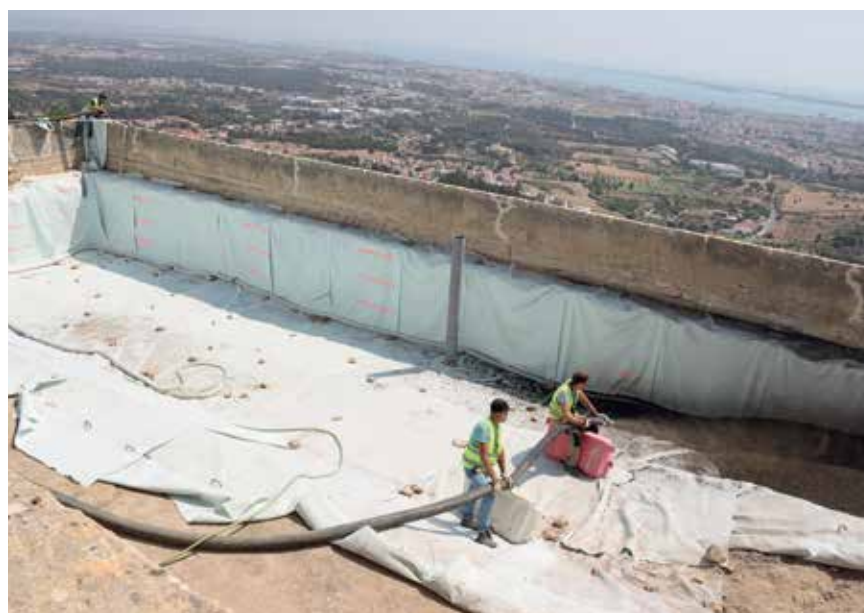
Leca letklinker blev blæst direkte fra lastbilen til hvor de skulle bruges.
