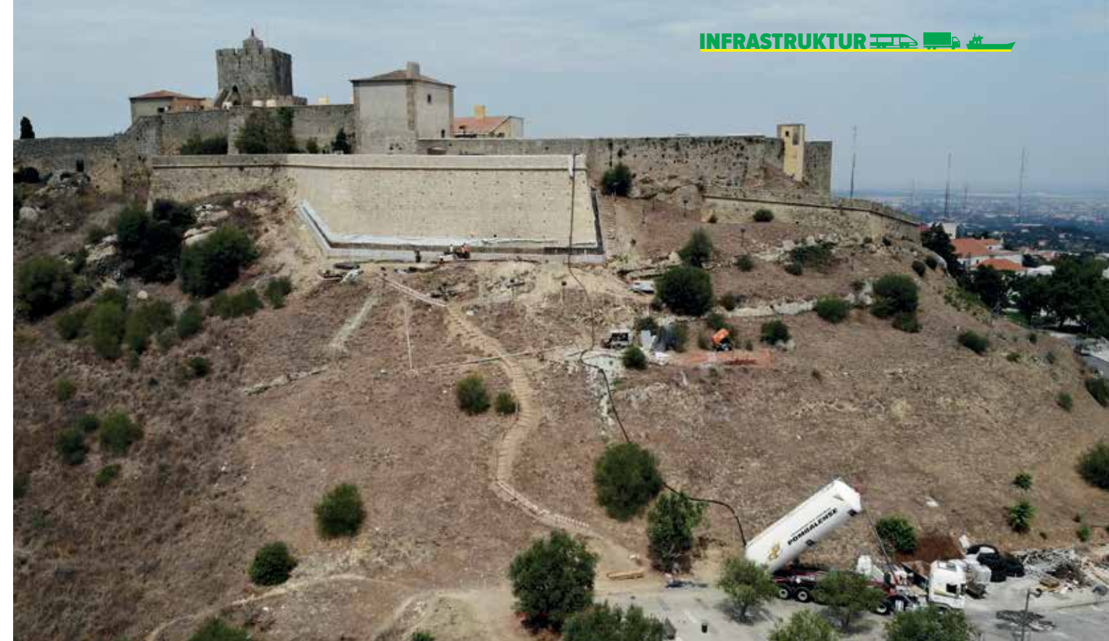
I 2015 vurderede National Laboratory for Civil Engineering sikkerheden i borgens skråninger som værende kritisk.
