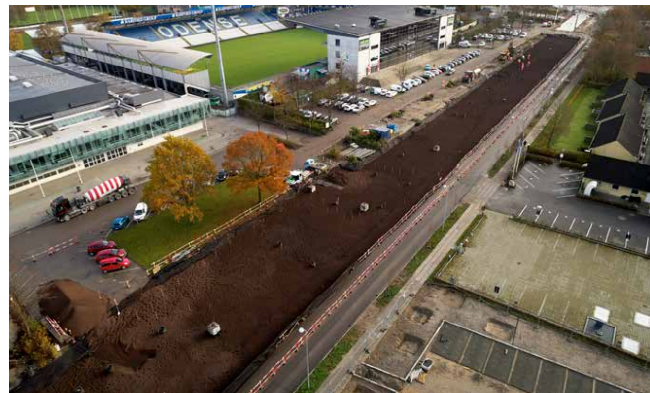
4200 m 3 Leca letklinker blev brugt til den 300 meter lange strækning.
