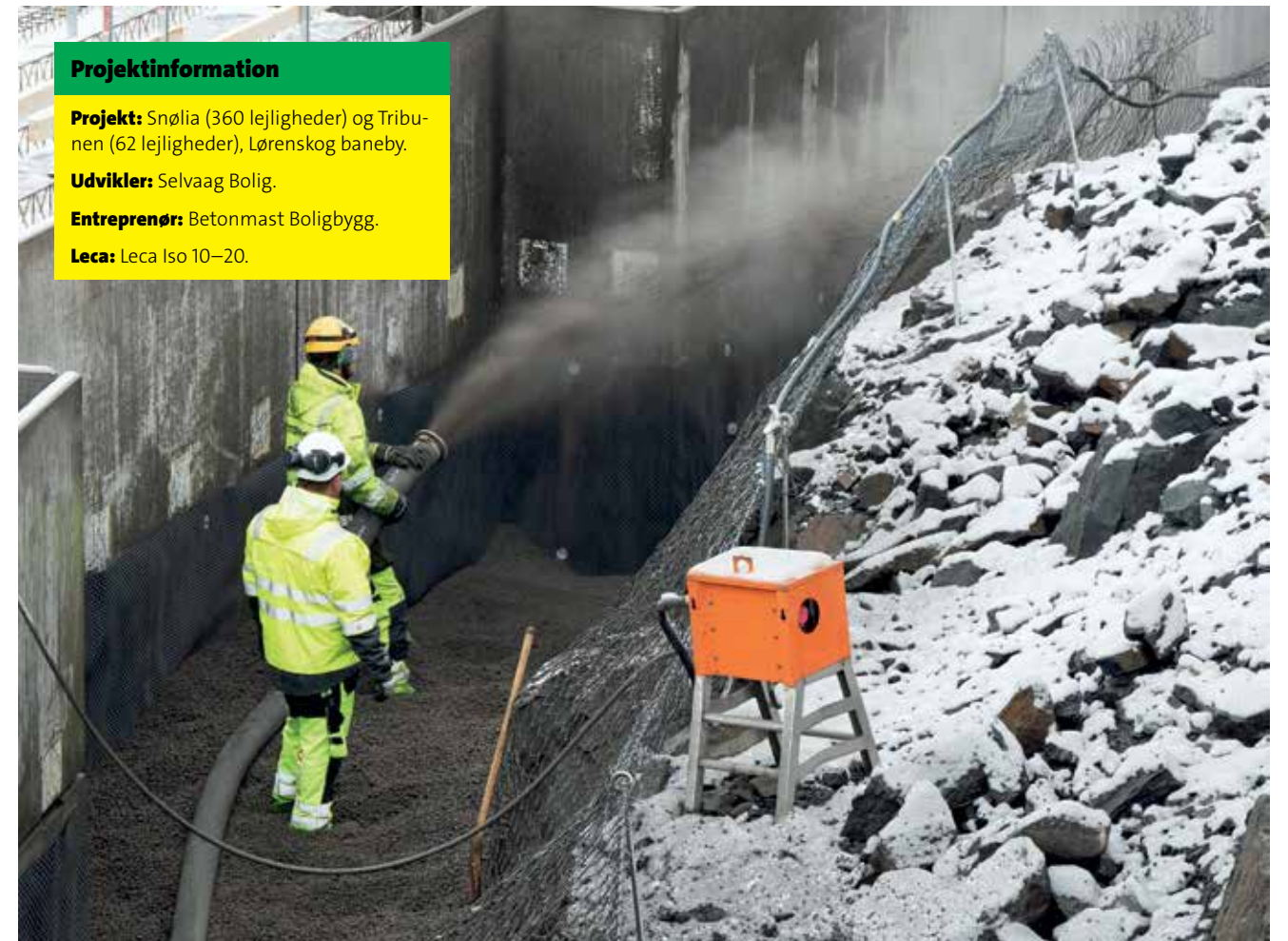
Andrzej Bojarczuk (til venstre) og Eirik Navelsaker sørger for, at udfyldningen ikke lægger for meget pres på bygningen.
