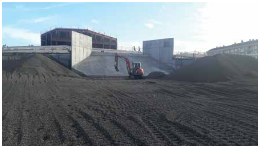
Arlita letklinker bliver komprimeret.
