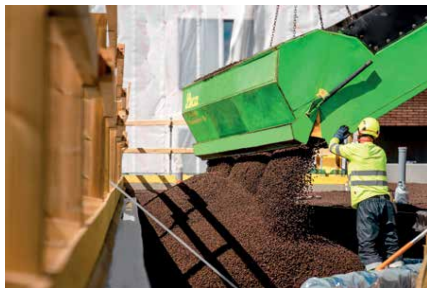
Letklinkerne blev hurtigt leveret med en løftekasse.
