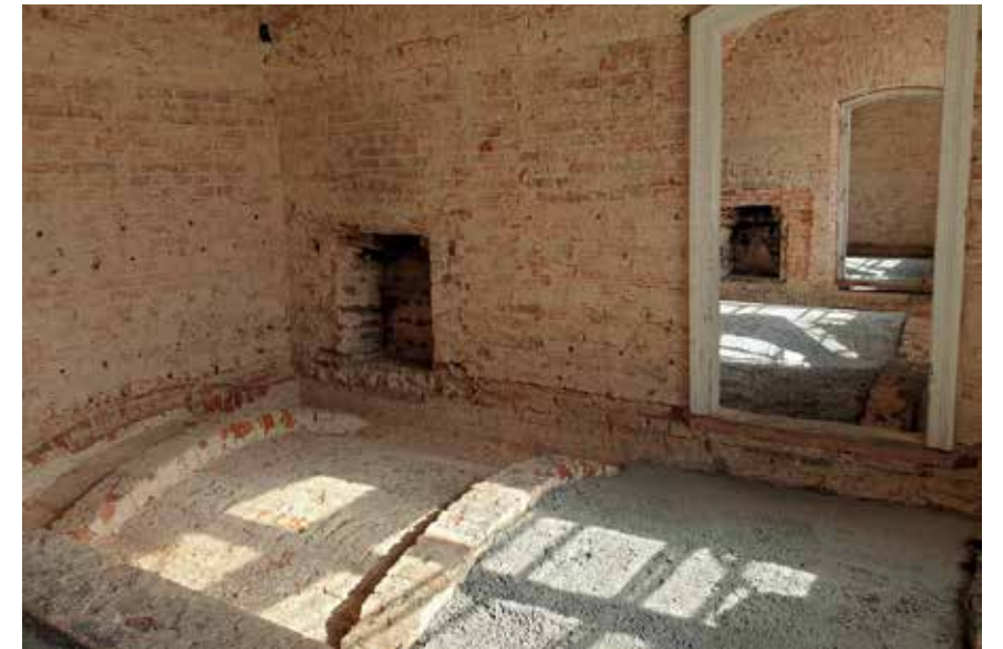
Et af de renoverede lofter/gulve.
