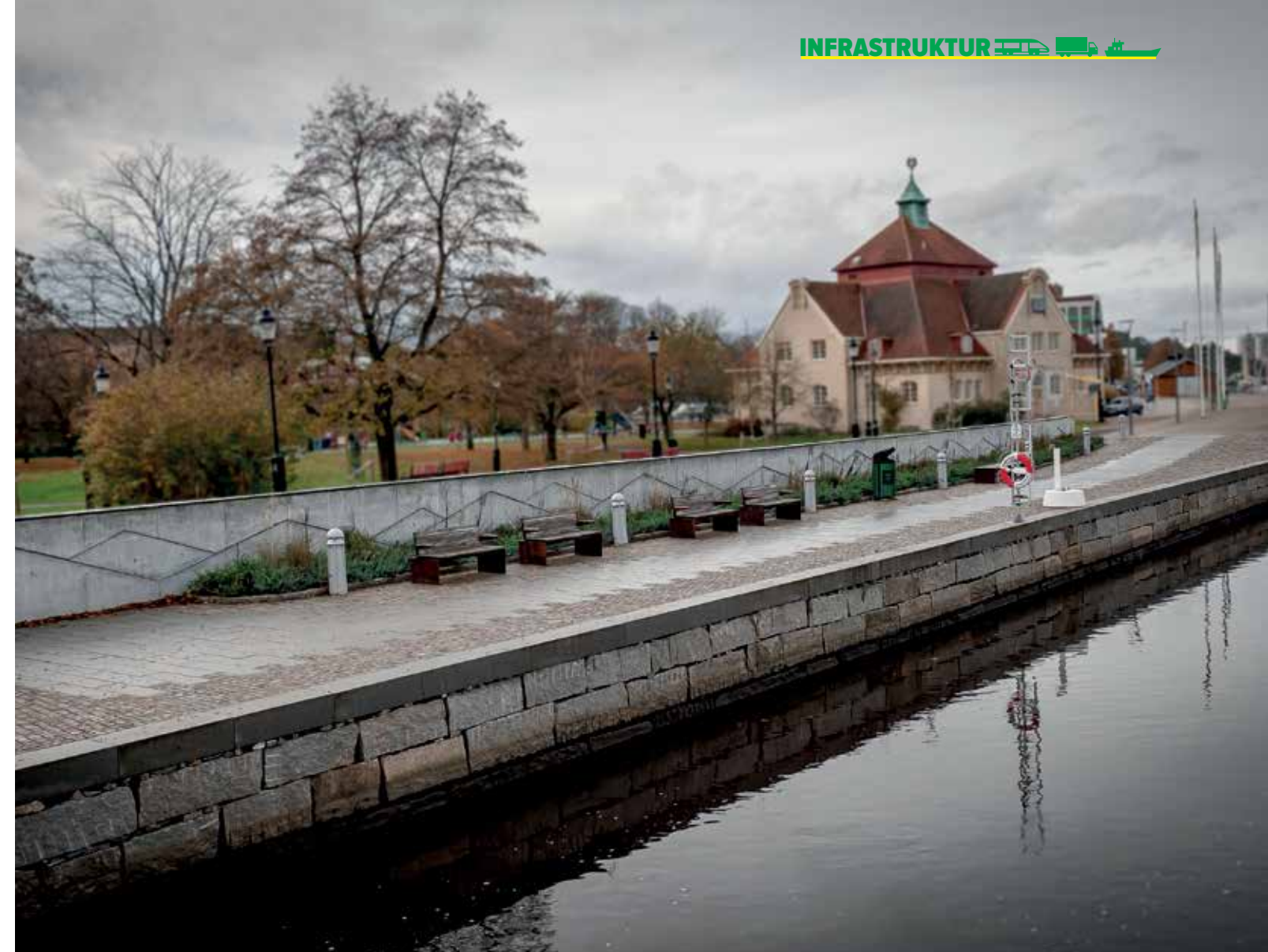
Renoveringen af kajen er nu færdig og konstruktionen forventes at kunne holde i meget lang tid.
