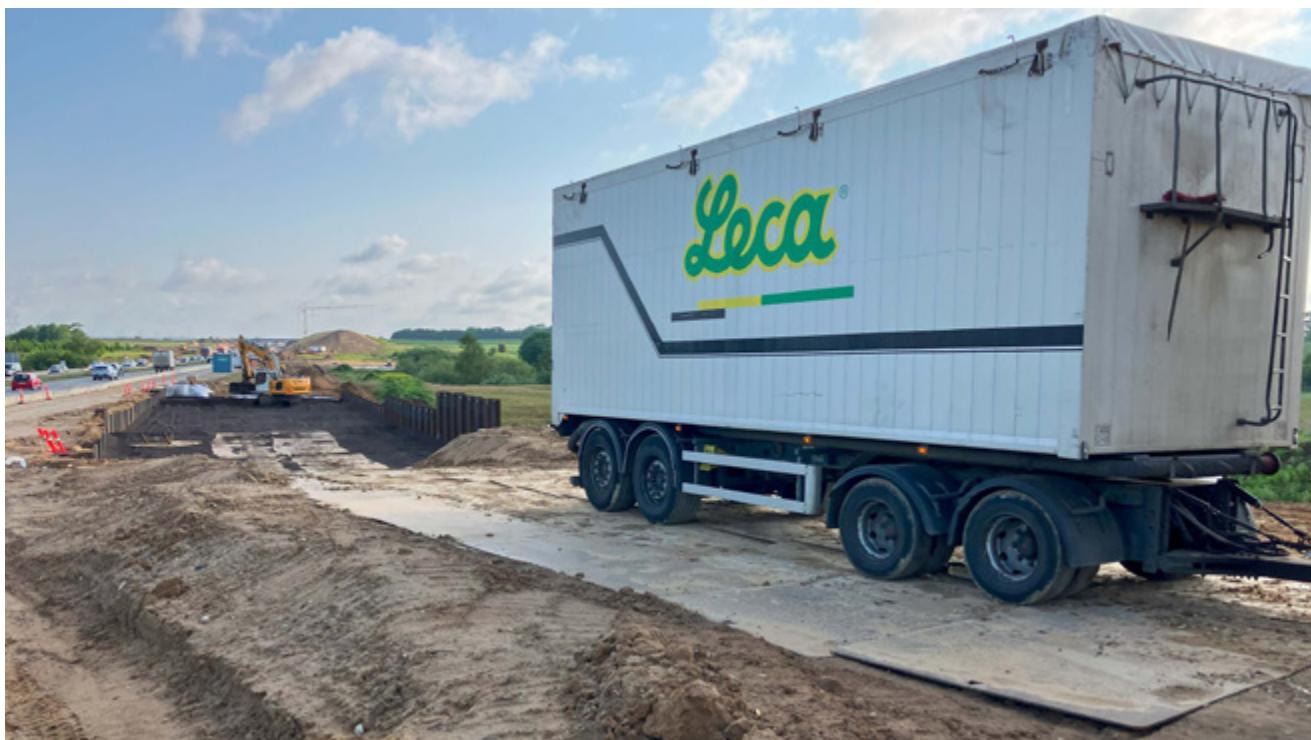
Levering af Leca® letklinker til E45-udvidelsen. Materialet ankommer klar til udlægning, hvilket sikrer en effektiv byggeproces.
