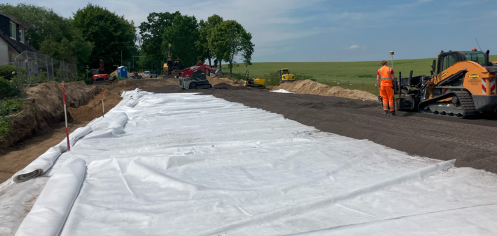
Leca® letklinker blev indkapslet i et geotekstil
