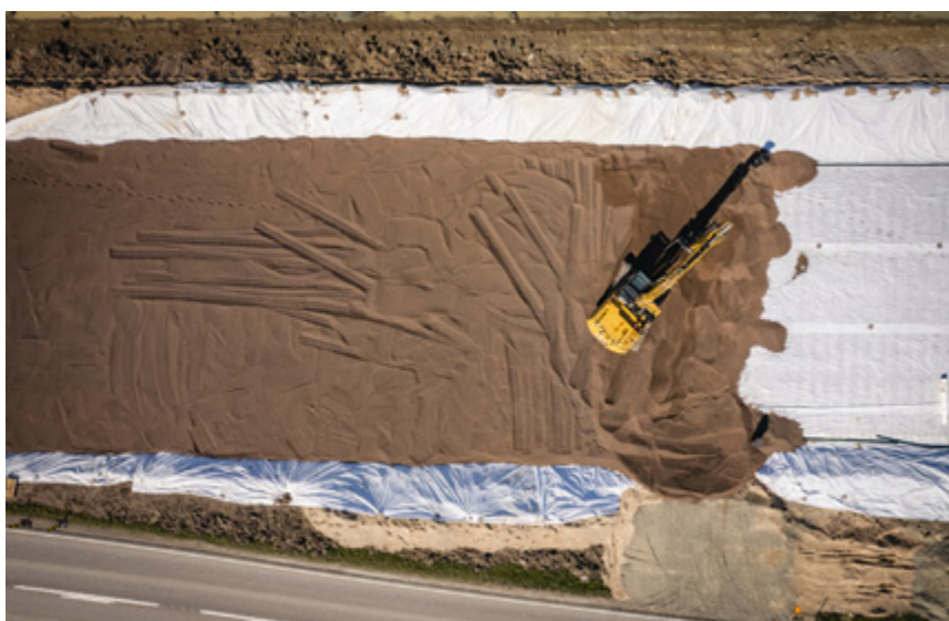
Leca® letklinker blev komprimeret med en bæltegraver.
