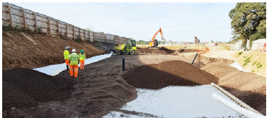
Over 5.600 m 3 Leca® letklinker understøttede rørlægningsudvidelsen, før jordarbejdet begyndte.
