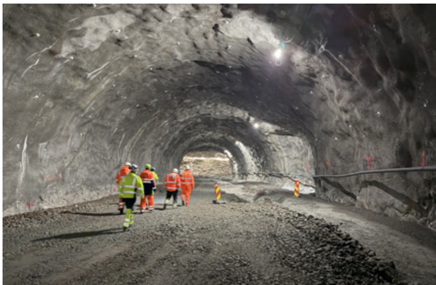
Projektteam på stedet i Brattfjelltunnelen, hvor Leca® letklinker bruges til frostbeskyttelse og dræning
