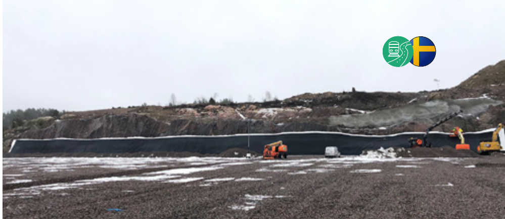
Færdiggjort del af inddæmningsstrukturen langs det tidligere stenbrud, klar til næste fase.
