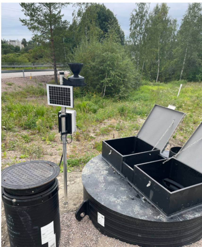
Filterkammeret kombinerer sedimentation og Filtralite P-filtrering.
