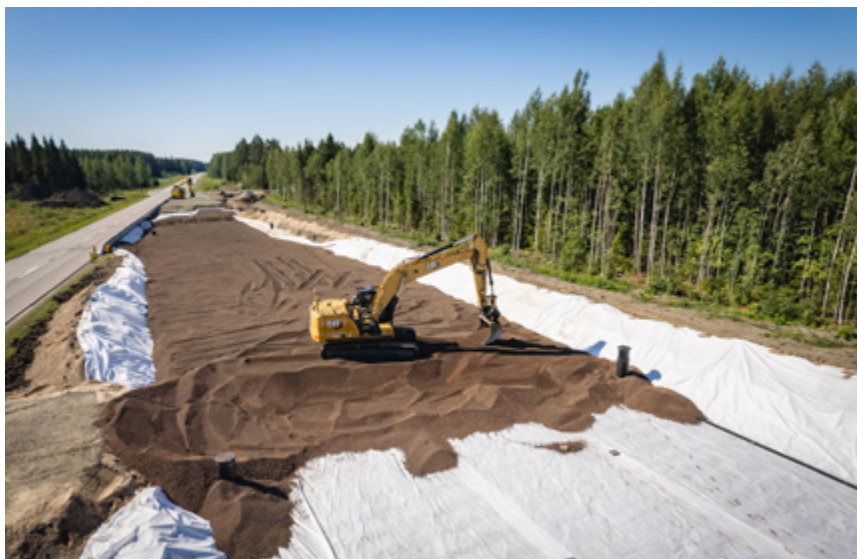
Leca® letklinker lag 1,3-3,3 m, omsluttet af geotekstil.
