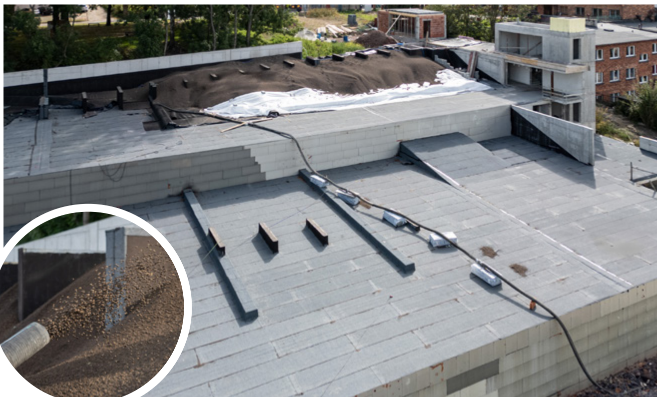
Leca® letklinker blev blæst direkte på tagkonstruktionen.
