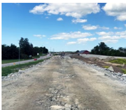
Jordarbejder på den nye motorvej, der forbedrer kapaciteten og sikkerheden for de 15.000 køretøjer, der passerer dagligt.
