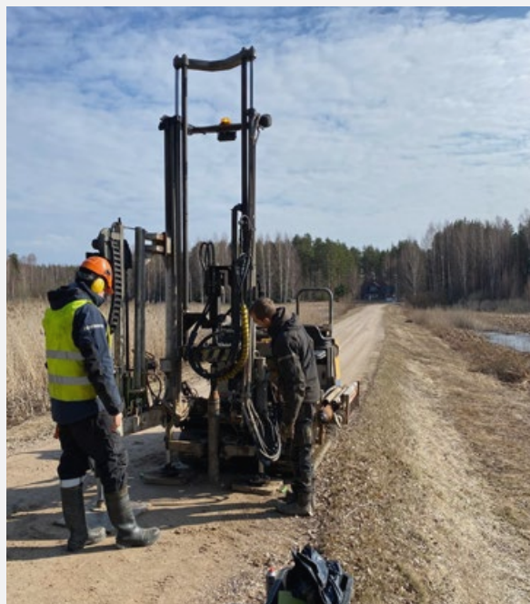
Prøveboring i marts 2024 for at vurdere tilstanden af Leca® letklinker i Varska-vejdæmningen.
