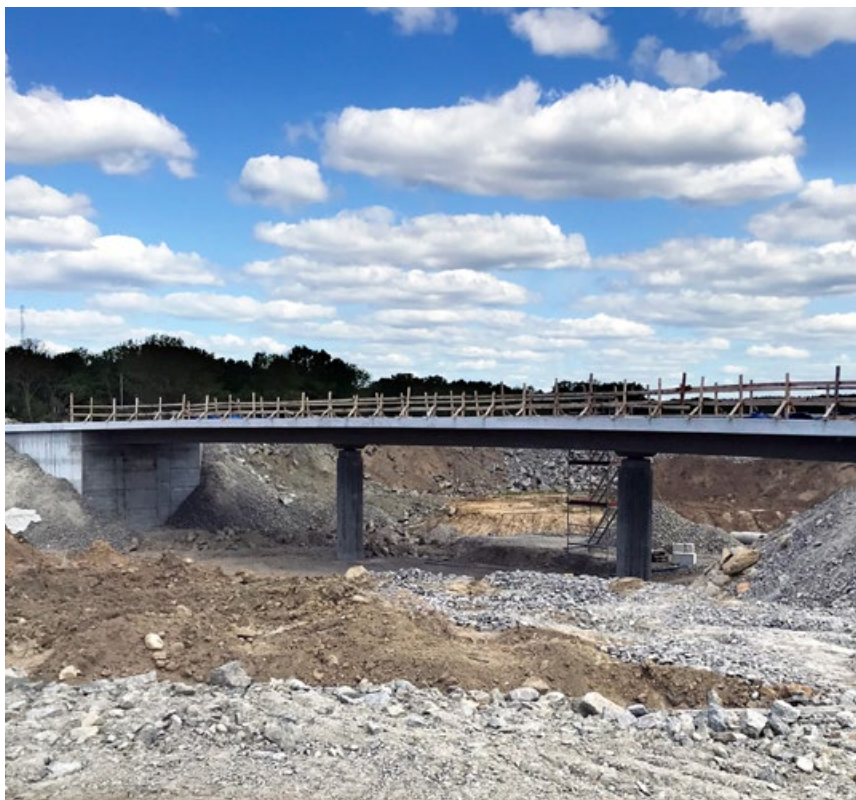
En af de 23 broer, der bygges for at forbedre infrastrukturen, hvor Leca® letklinker forhindrer yderligere pæling.
