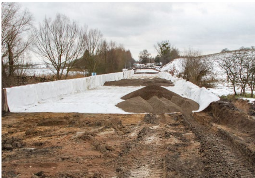
Det blev besluttet at bruge en geomadrass lavet af Leca® letklinker 8/10-20RX.”
