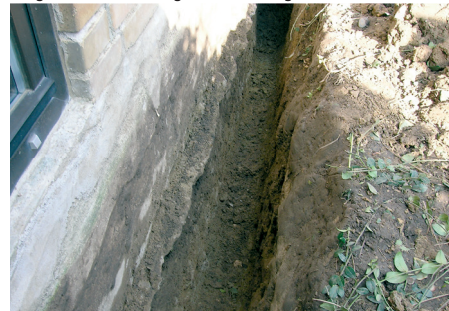
Udgravet rende langs kældervæg.
