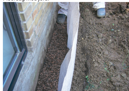
Løse Leca® letklinker hældt i renden. Fiberdug mod jord.
